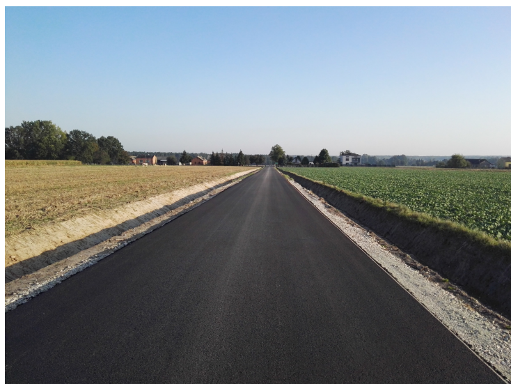
Modernizacja drogi Wdowin Kolonia – Suchcice (550 000,00 zł)
