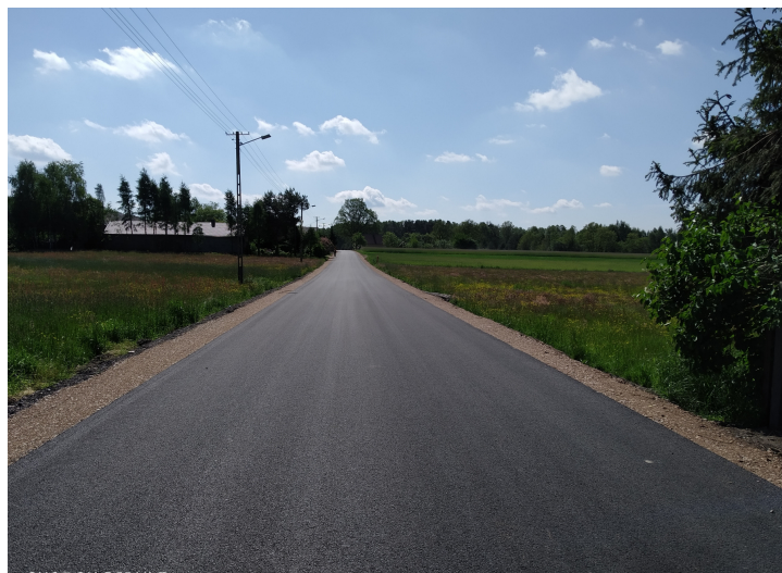
Przebudowa drogi Pieńki Głupickie (1,1 mln zł)
