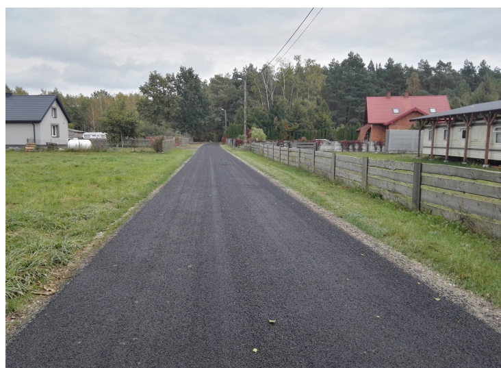
Modernizacja drogi gminnej Rawicz (110 000,00 zł)
