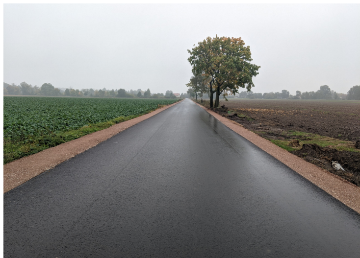
Przebudowa drogi Bukowie Dolne – Katarzynka (1,9 mln zł)
