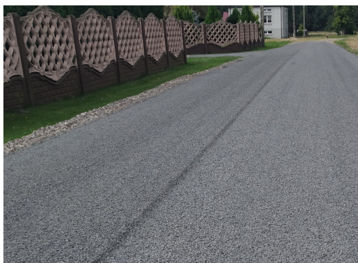
Modernizacja drogi gminnej Łęczyca (60 000,00 zł)
