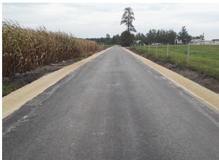
Modernizacja drogi gminnej Gręboszów (800 000,00 zł)
