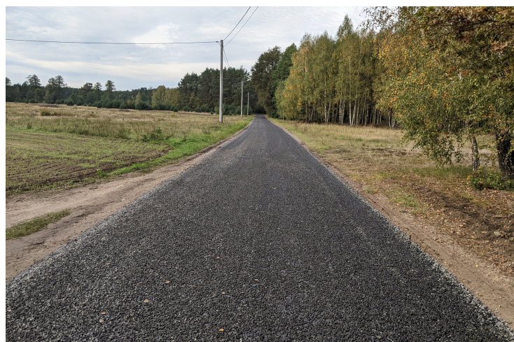
Modernizacja drogi Zabiełłów (335 600,00 zł)
