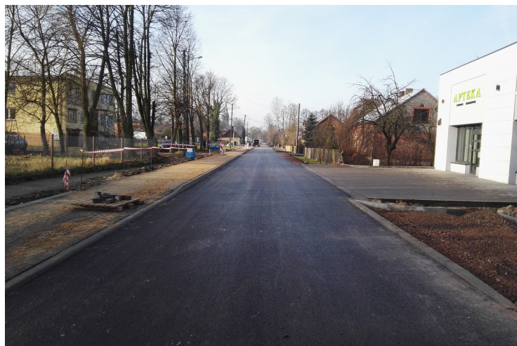
Przebudowa drogi gminnej Drużbice Kolonia (1,2 mln zł)
