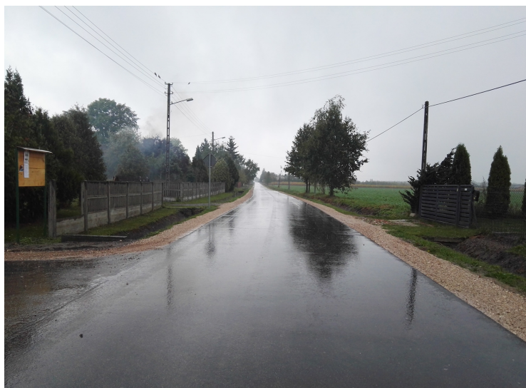
Przebudowa drogi gminnej Rasy – Bukowie Górne (779 982,00 zł)
